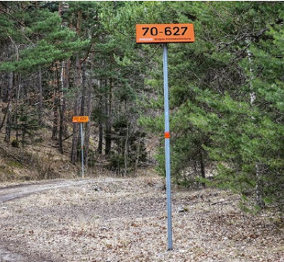
Gasleitung im Wald
