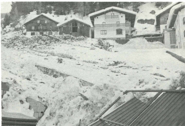
Diasbachlawine. Beschädigung der Tiwag-Garage (zu Nr. 250)
