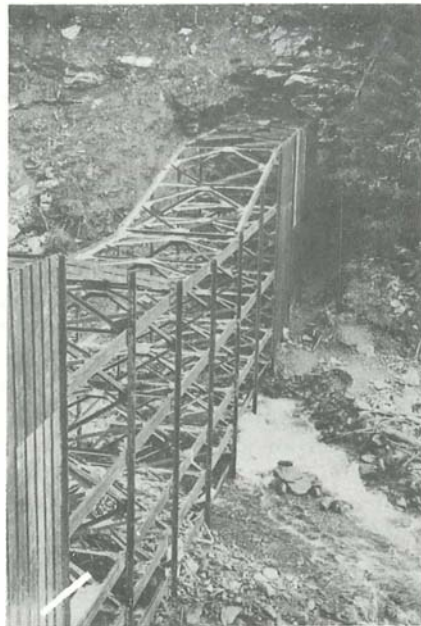
Abb. 20: Seitenansicht der Gitterrostsperr im Dürnbach
