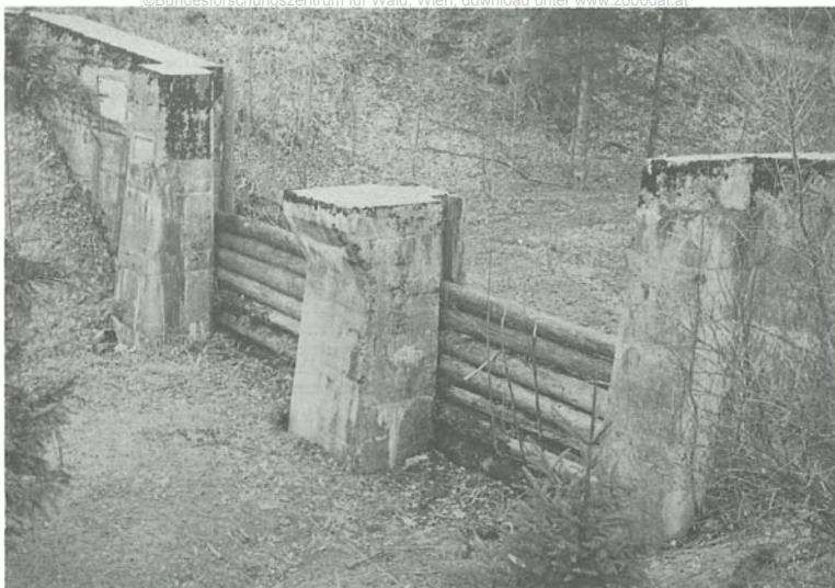
Abb. 5: Balkensperre mit auswechselbaren Holzbalken und Stahlbetonpfeilern im Keerbach in Niederösterreich, nach der sog. Tauschwandbauweise (ZARBOCH bei STRELE 1950) aus dem Jahre 1936, mit talseitiger (oben) und bergseitiger Ansicht (unten) Aufn. Dipl.Ing. Ruf
