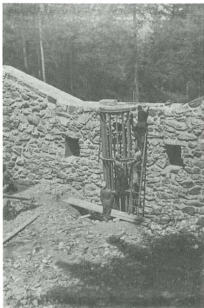
Abb. 2: Montage des Geschiebekorbes im Lünitzbach (Abb. 1)
