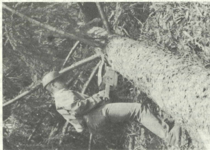
Abb. 5 und 6: Gekommte Motorsägenarbeit beim Entasten; das Abstützen der Säge und der sichere Schnittstand ist aus beiden Bildern besonders zu ersehen.
