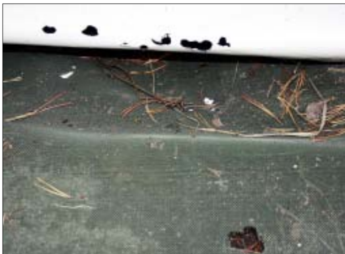
Abbildung 4: Nageschäden durch Mäuse an der Folie und am eigentlichen Mäuseschutzgitter
