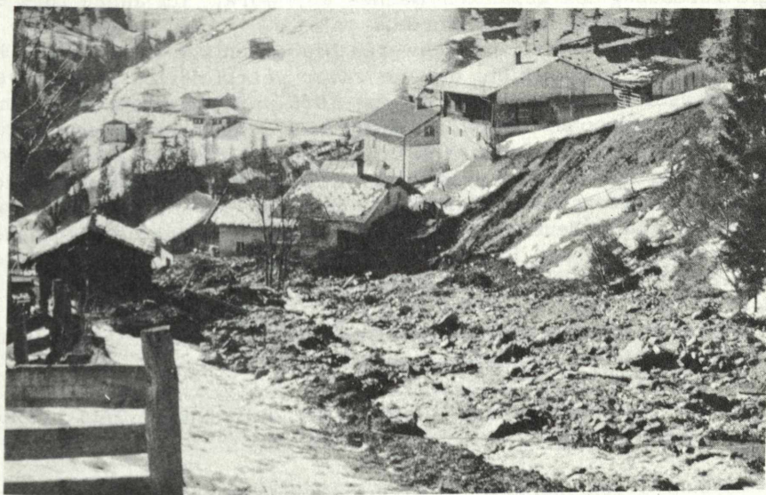
Abb. 4: Geschiebeablagung im Ortseingang.
