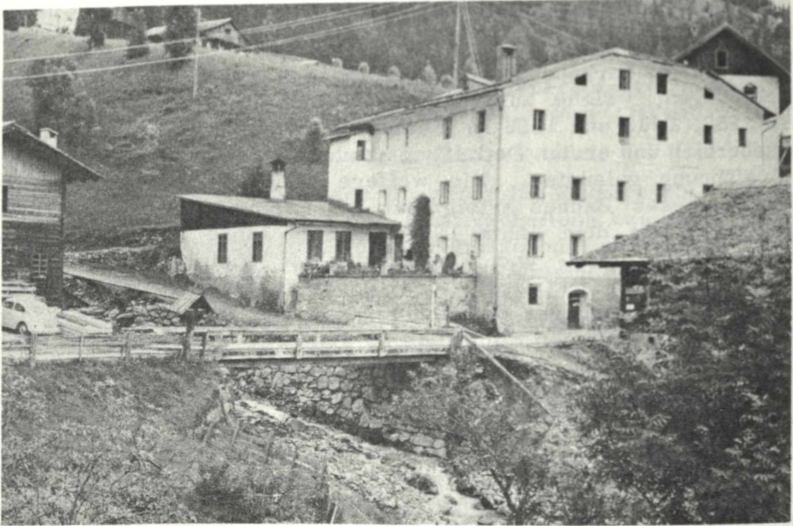
Abb. 1: Die Bundesstraßenbrücke im Trattenbach im Jahre 1956.
