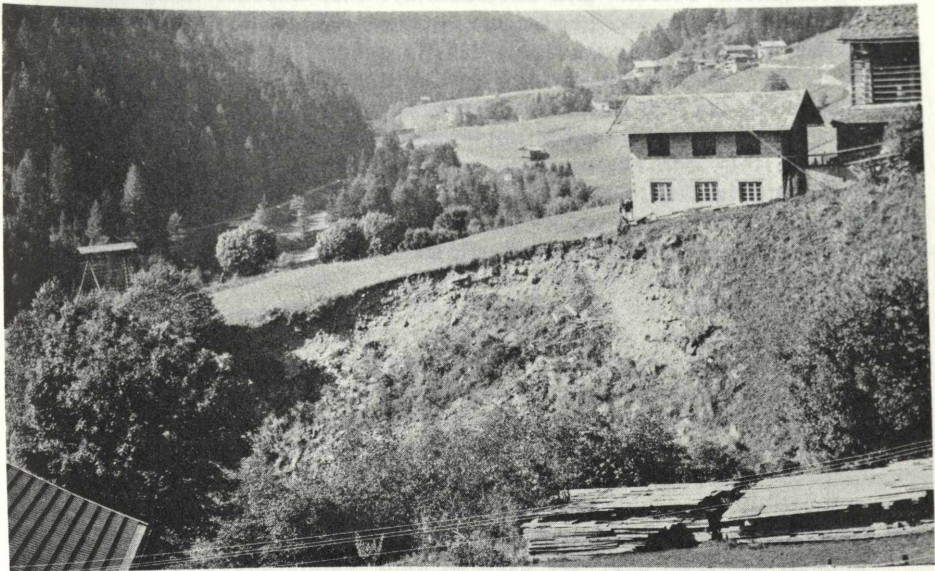
Abb. 2: Seitenschurf im Bereiche des Unterlaufes des Trattenbaches (etwa hm 2).
