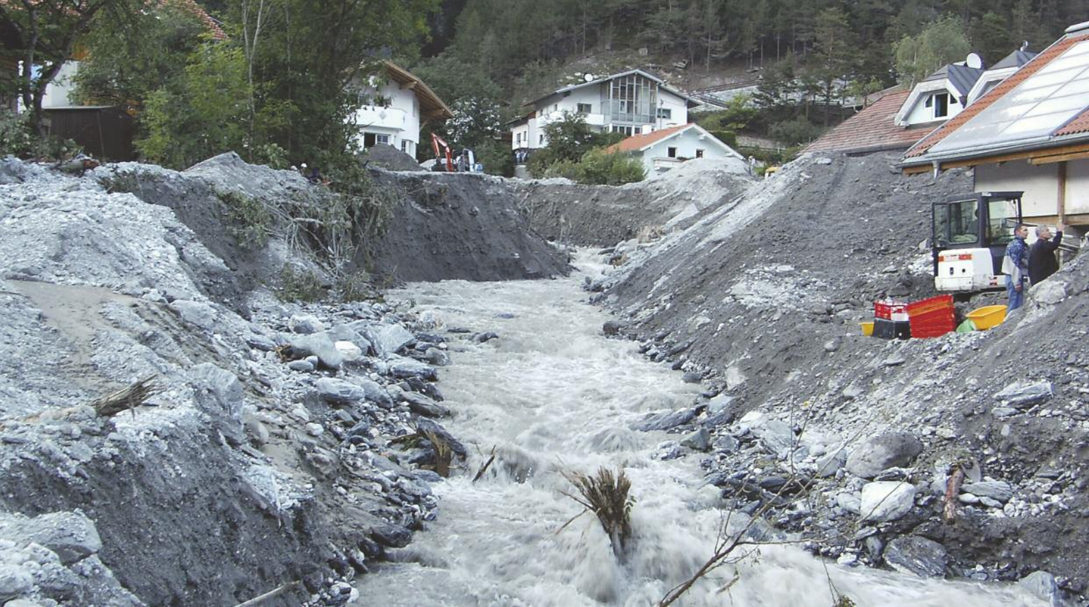
Der Stubnerbach verursachte 2005 ein Hochwasser in Pfunds
