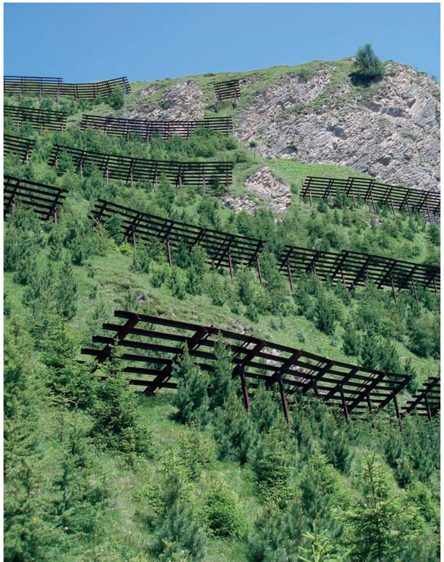
Abbildung 1: Techn. Lawinverbauung mit Hochlagenaufforstung, oberhalb der Gemeinde Spiß (Tirol - Bezirk Landeck), Juli 2007
