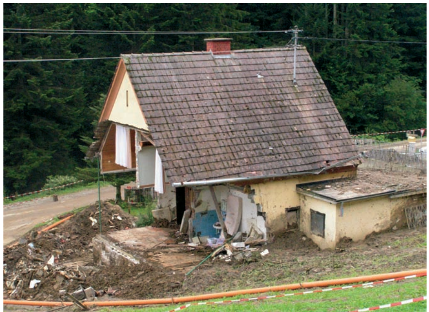
Wohngebäude durch eine Hangmure zerstört (Steiermark, 2005)
