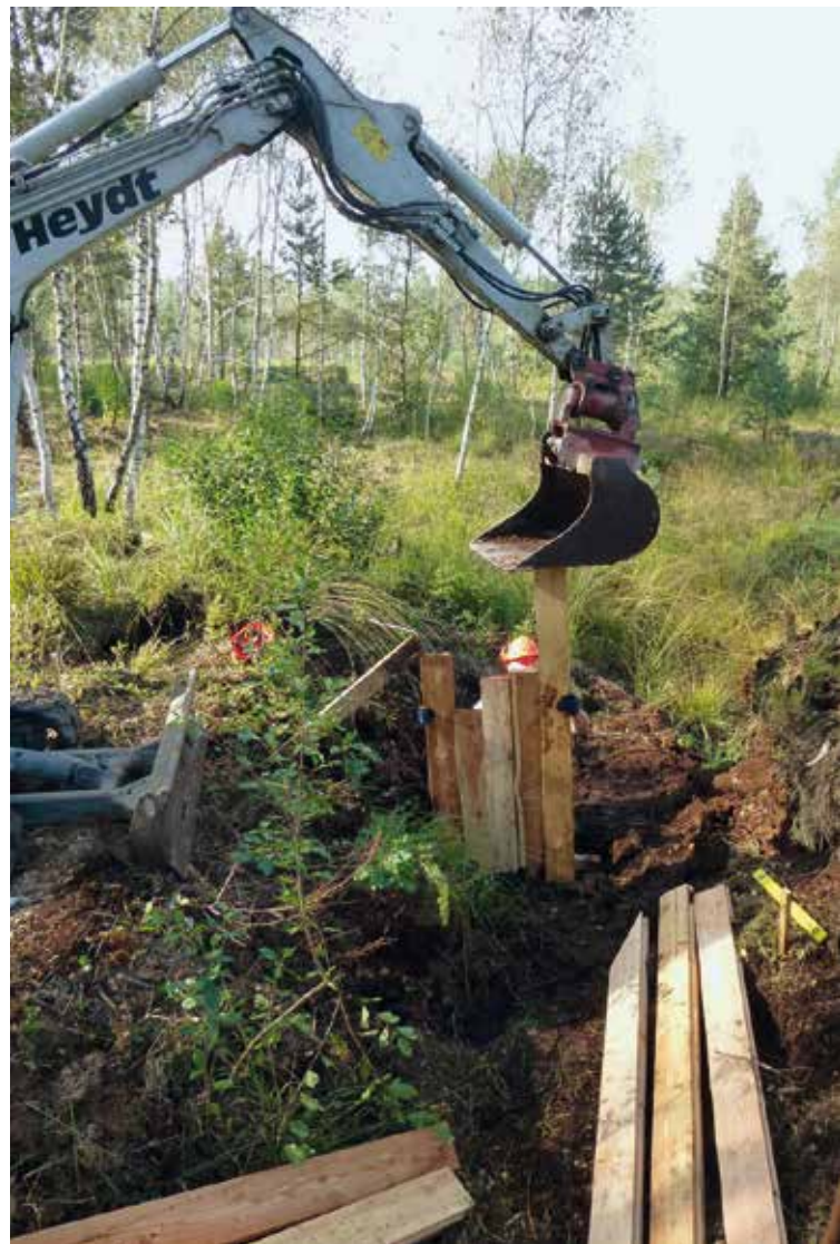
Abbildung 1: Vorarbeiten zur Wiedervernässung im Tannhäuser Ried
